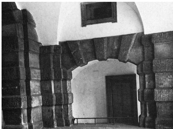
Průjezd severní brány –Antonio Brocco, Praha - Hrad
